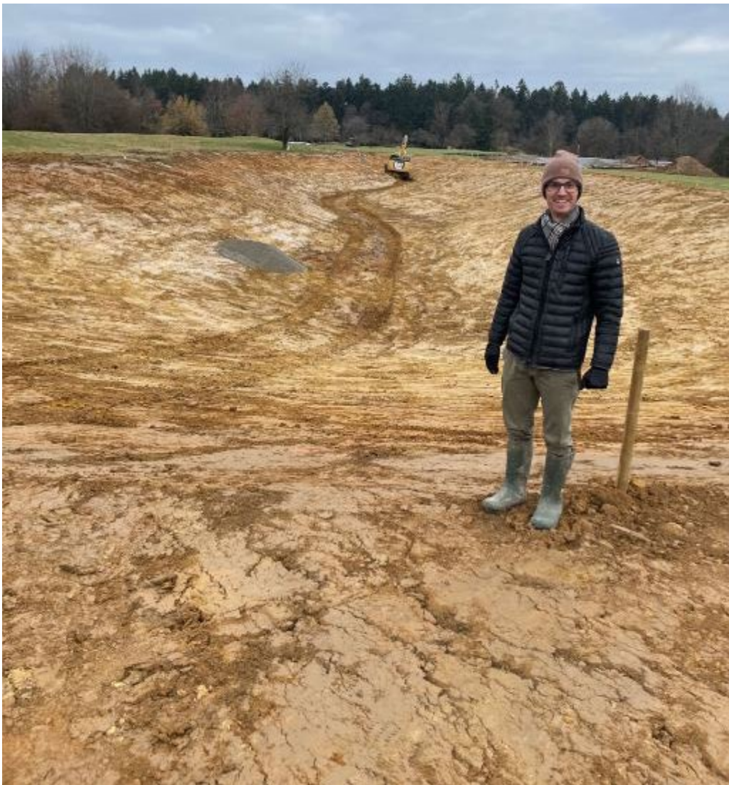
Unser Golfplatzarchitekt Philipp Schwab im Einsatz am 4er See während der Bauphase
